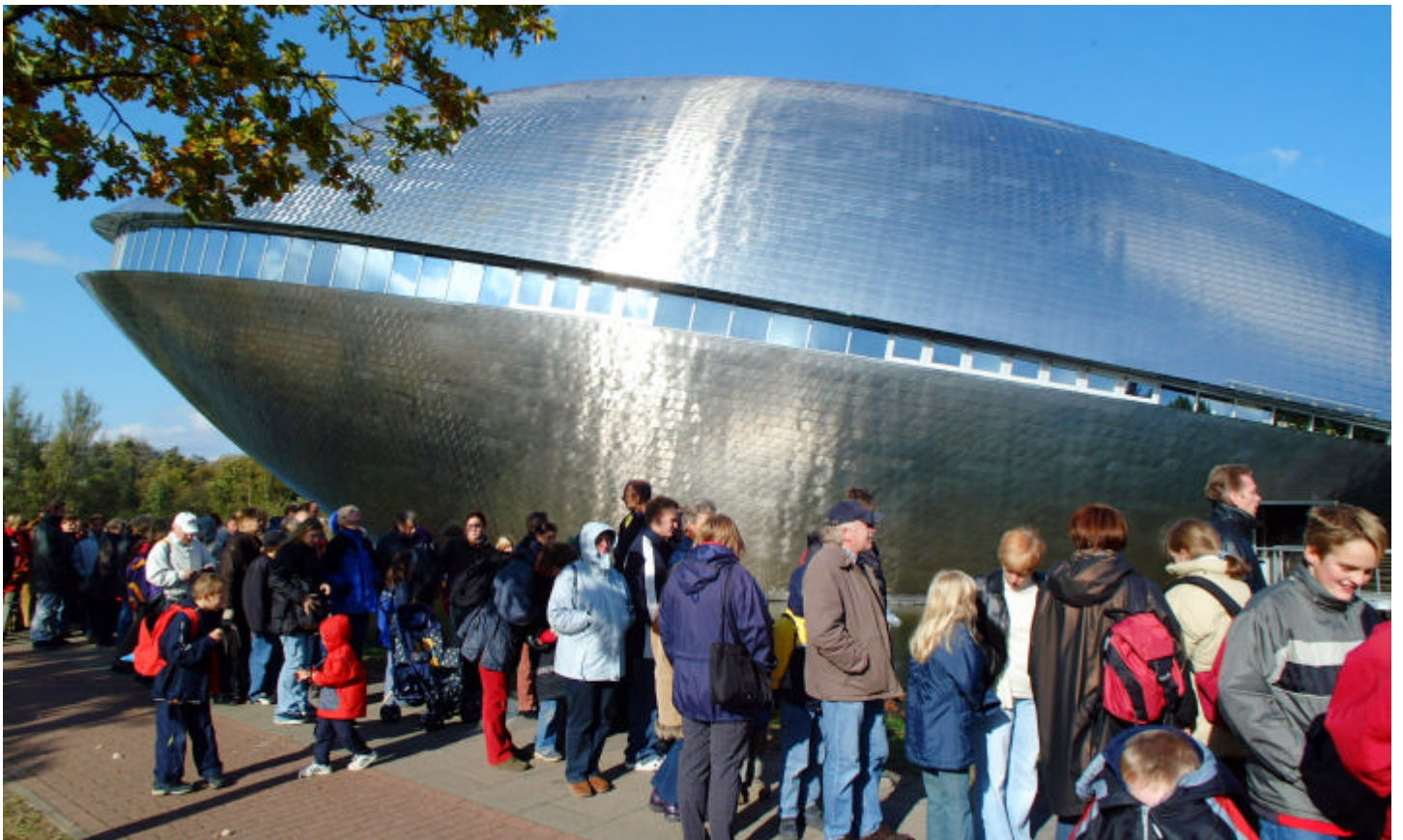
25 trapezförmige RWA-Drehflügel / Öffnung ca. 70° 5 Fluchttür-Steuerungen in Sonderausführung
