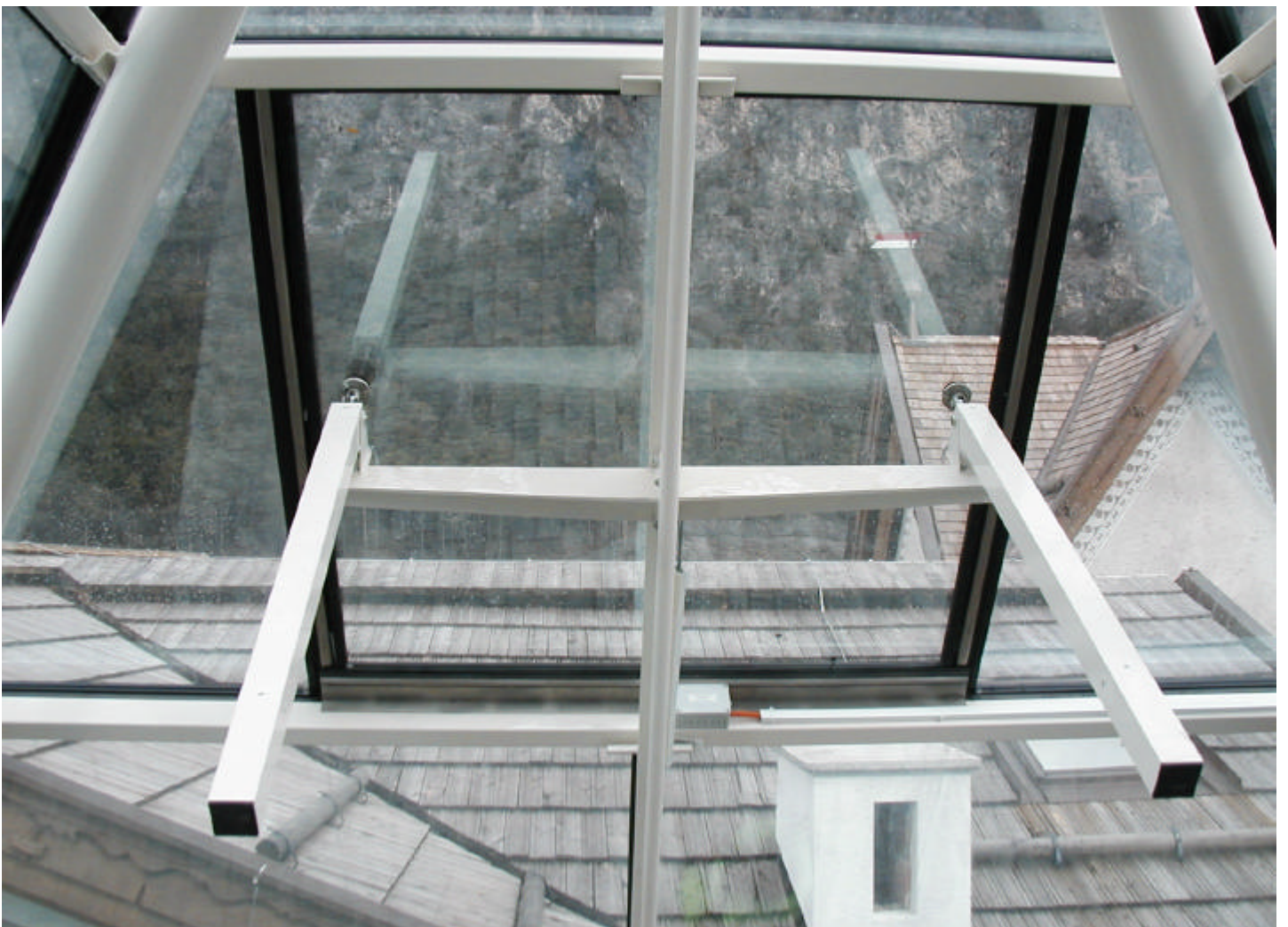
RWA-Flügel „Ganzglas“ in Glaspysramiden Betätigung über Synchronantriebe SG 150 (1500 N pro Antrieb) Öffnungsweite 800 mm gem. Brandschutzgutachten
