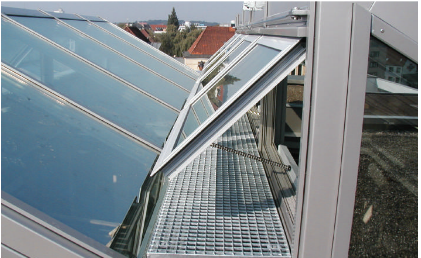
11 RWA-Flügel „Klappflügel“ unten auswärts öffnend mit WERO-Kettenantrieben KA 30 / 24 V DC
