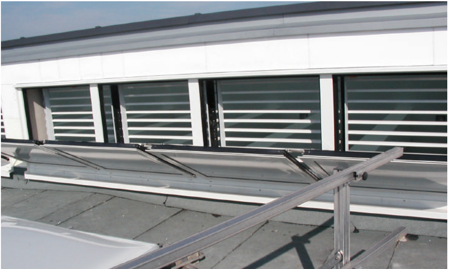
8 RWA-Kippflügel (auswärts öffnend) Öffnungsweite 70° gem. Brandschutzgutachten 2 Antriebe pro Flügel im Tandem-Betrieb
